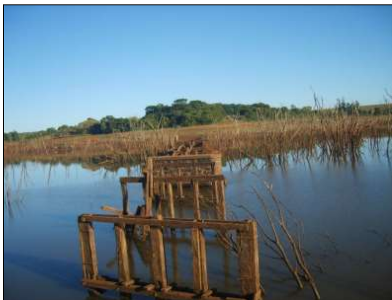
Fotografia 3: A seca expôs as estruturas de uma antiga ponte.
