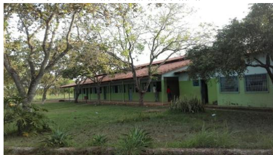
Foto nº 02. Pavilhão de salas de aula
