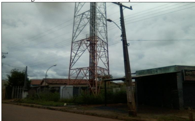
Fotografia 6: Torre de telecomunicações
