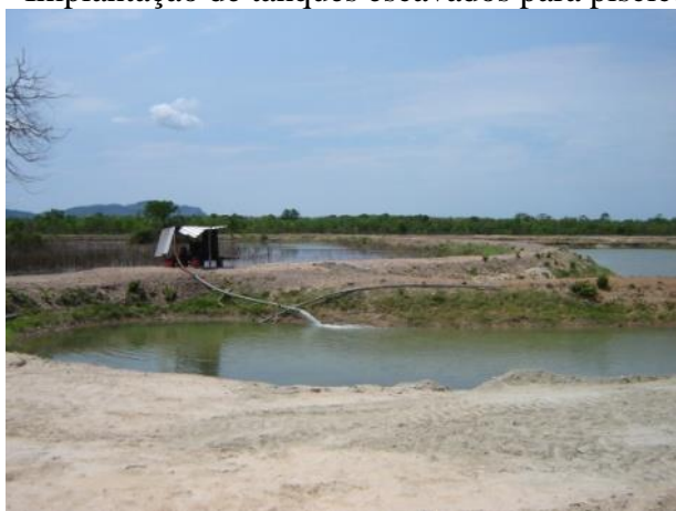
Figura 14 – Implantação de tanques escavados para piscicultura – TO.
