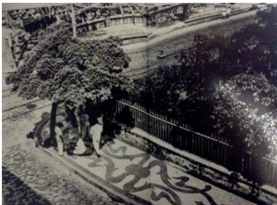
Figura 3: Fotografia de Benício Dias. A esquina da antiga igreja dos ingleses, na Rua da Aurora, no Bairro da Boa Vista. Coleção da Fundação Joaquim Nabuco, Recife – PE.
