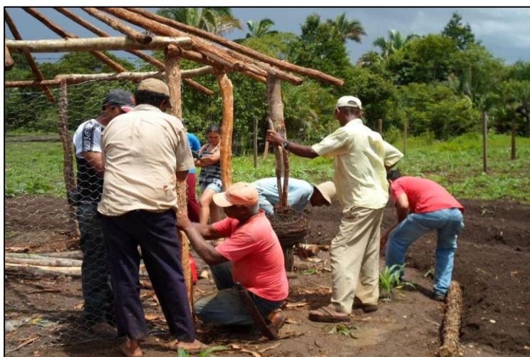
Figura 6: Construção do PAIS em mutirão
