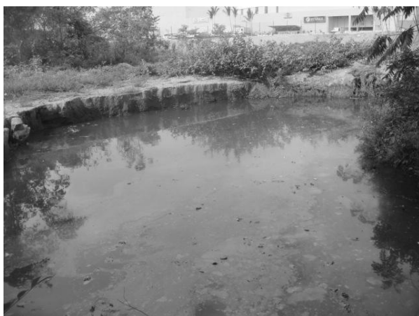
Figura 9. Córrego Brejo Comprido: degradação ambiental pela construção do Capim Dourado Shopping no ponto P4, 2010. Foto: Iraci C. Menezes.
