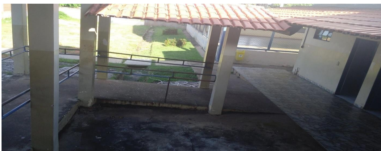
Figura 4 – Acesso à quadra esportiva e banheiros.
