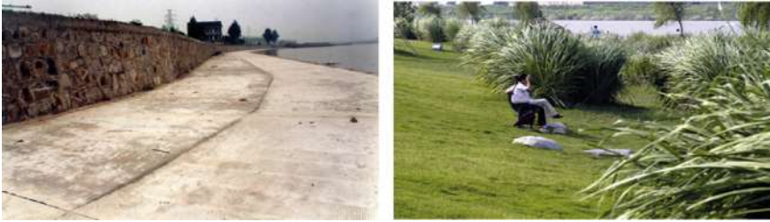
Figura 84 e Figura 85: Foto de antes e depois da intervenção do parque.
