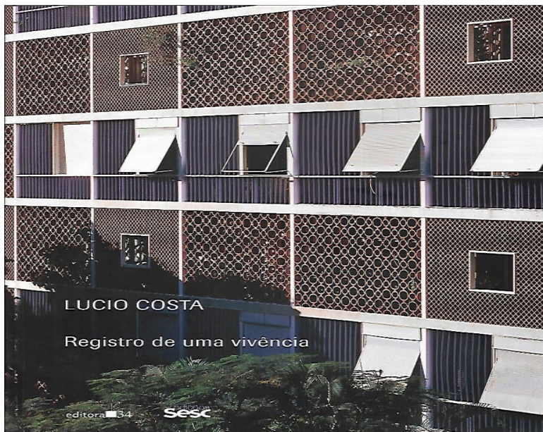
Figura 2 - Fachada de um dos Blocos Residenciais do Parque Guinle onde é possível ver os muxarabiês
