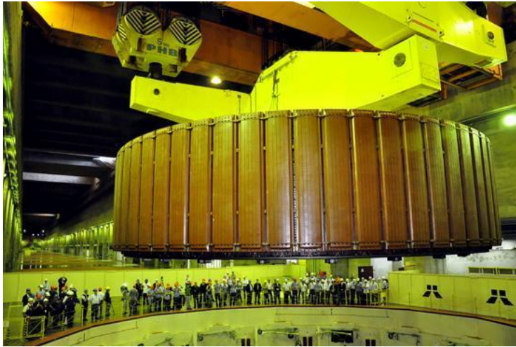
Figura 2.8 - Rotor de 78 polos de um gerador da UHE de Itaipu. Fonte: (ITAIPU. BINACIONAL, 2010).
