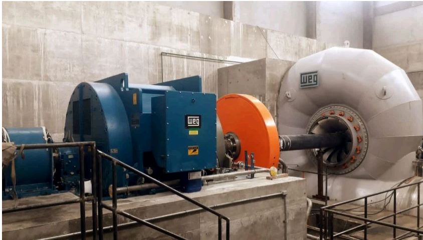
Figura 2.7 - Conjunto Turbina-Gerador com volante de inércia. Fonte: (Weg, 2023).
