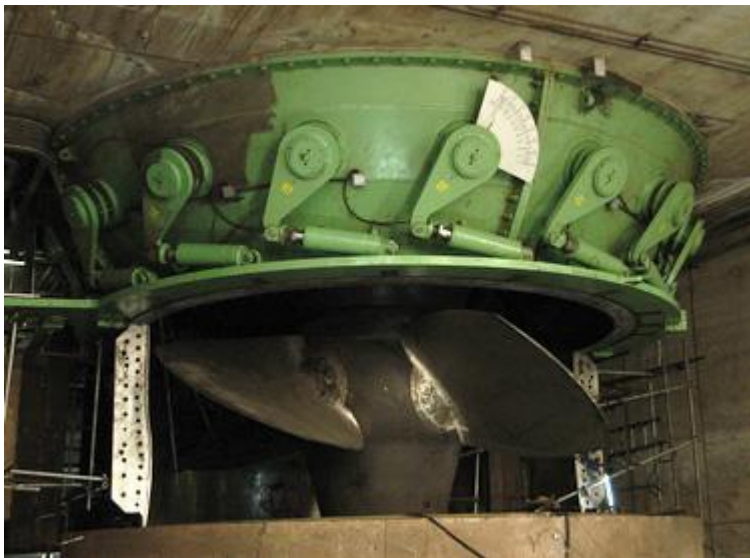
Figura 3.22 - Rotor de uma turbina Bulbo de 4 pás e distribuidor de 16 palhetas. Fonte: (UHE Igarapava, [s. d.])
