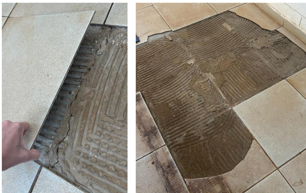
Figura 7 – Desplacamento cerâmico
