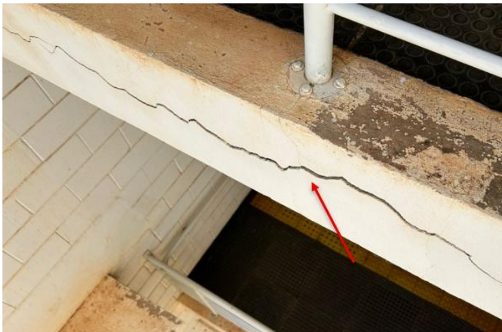
Figura 10 – Rachadura em viga
