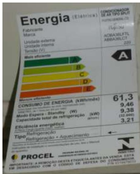
**Figura 4:** Etiqueta Nacional de Conservação de Energia presente em um modelo de condicionadores de ar do Bloco 3P.
