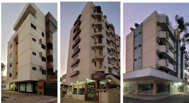
Figura 5. Imagem dos edifícios verticais mistos na Quadra 104 Norte.
