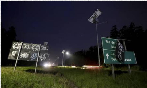
Figura 4: Deterioração e má conservação do Arco Metropolitano.
