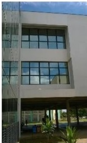
Vidraça voltada ao Norte, e vedação da rampa adjacente em vidro voltada a Oeste. Reflexo da vidraça Oeste da rampa incidindo sobre parede oposta
