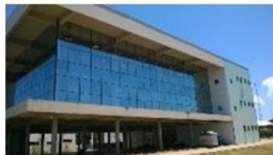
Fachada Sul com vidraça recuada.
