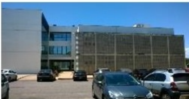
Fachada Norte com elemento vazado protegendo parte da fachada.
