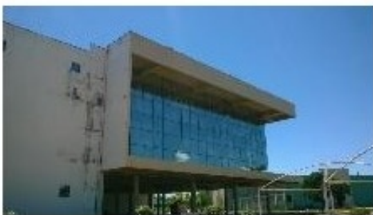
Fachada Oeste, com vidraça recuada.
