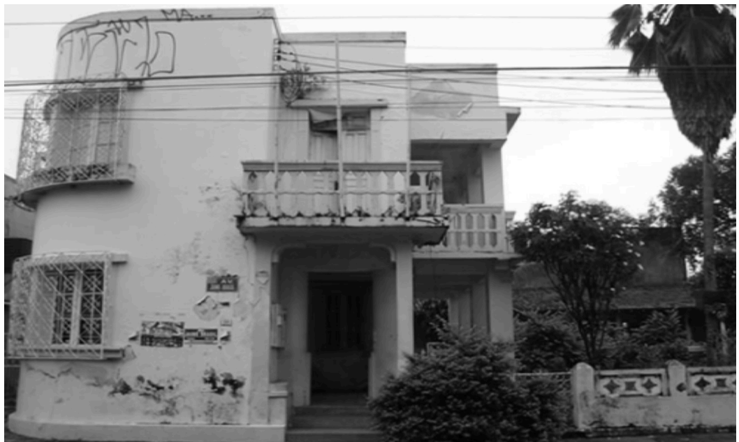
Figura 4 - Casa da Cultura, na Avenida Jaime Brasil - Centro de Boa Vista. Monumentos tombados pelas entidades que deveriam zelar pela manutenção do patrimônio histórico, em nítido processo de degradação. Fonte: Ayana Dantas, 2015.
