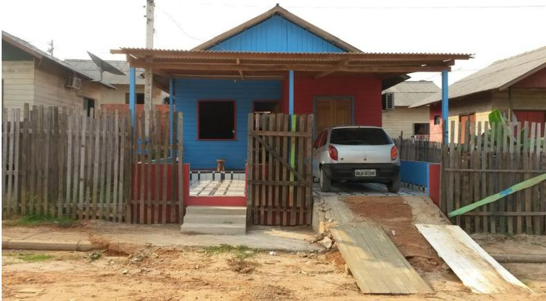
Figura 9 - Reforma e ampliação de varanda frontal com escada e rampa avançando a calçada e rua
