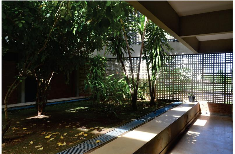
Figura 6 - Centro de Ensino Médio: pátio interno com jardim, composto por elementos vazados, cobogós proporcionando ventilação permanente. Acervo GPAC, 2017.
