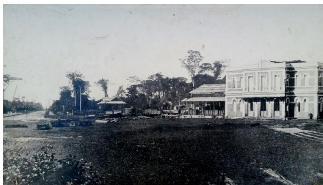
Figura 4 – Vista da Estação de São Brás após a sua inauguração
