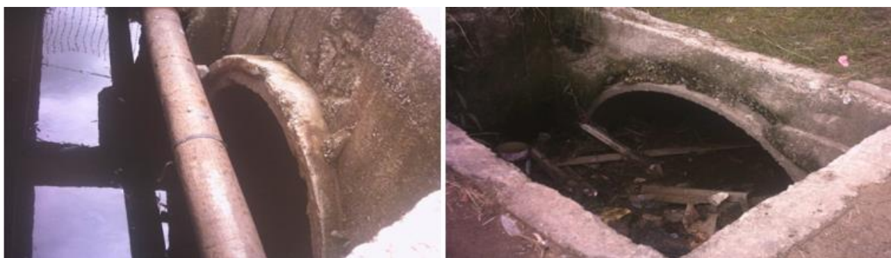
Figura 2 - Construção da EET (Fonte: Francisco Xavier)
