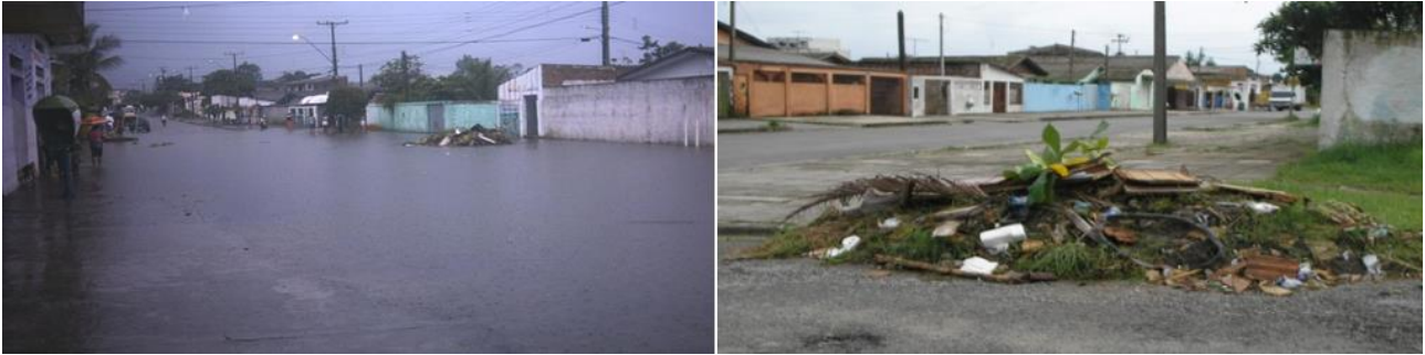
Figura 3 - Alagamento Rua Francisco Machado
